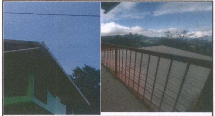
Foto 8: Mantenimiento a barandas de metal 50 M2
