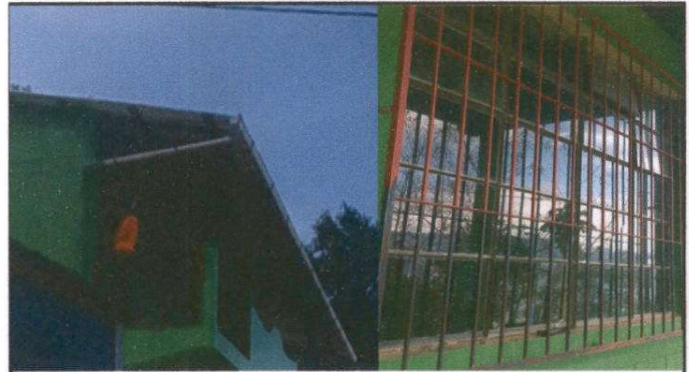
Foto 4: Mantenimiento a balcones de metal 50 ML
