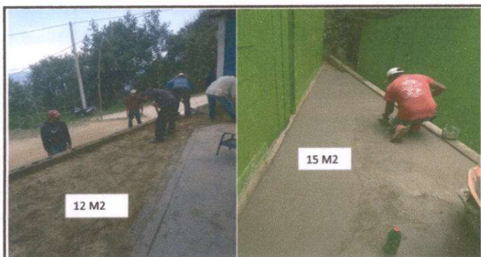
Foto 11: Losa de patio 27 M2
