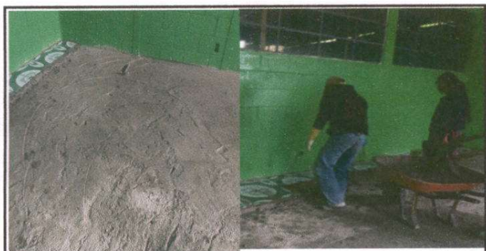
Foto 5: Sustitución de piso cerámico 68 M2
